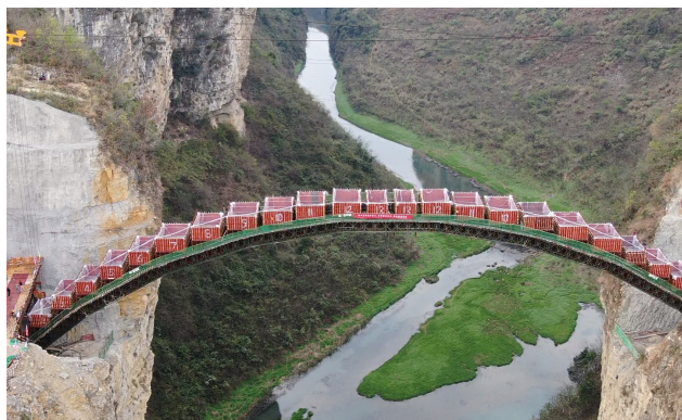
图：夹岩工程施工中的西溪河拱桥（荷载试验）
